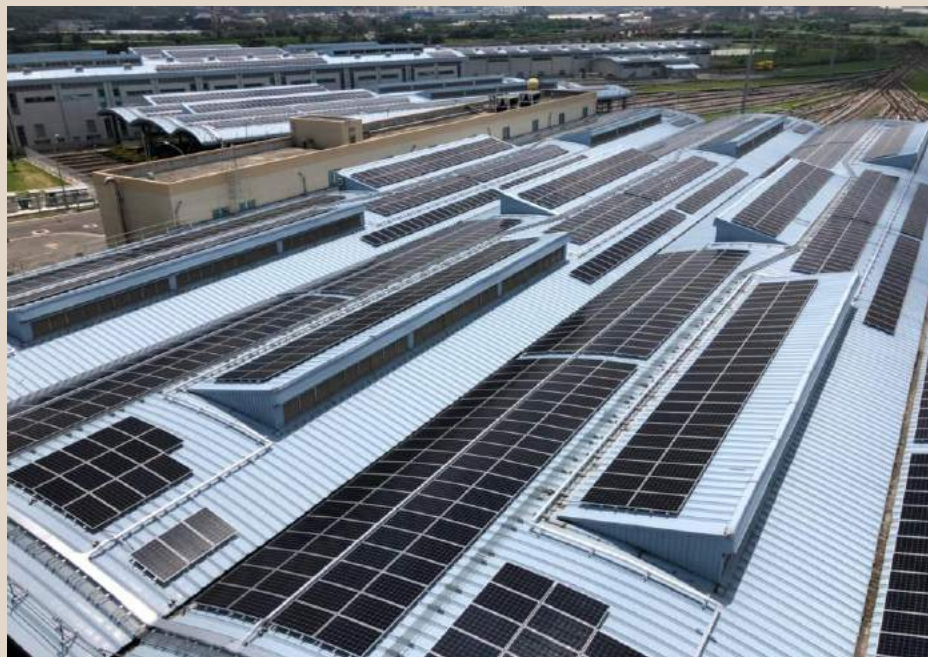
蘆竹機廠1.9MW
