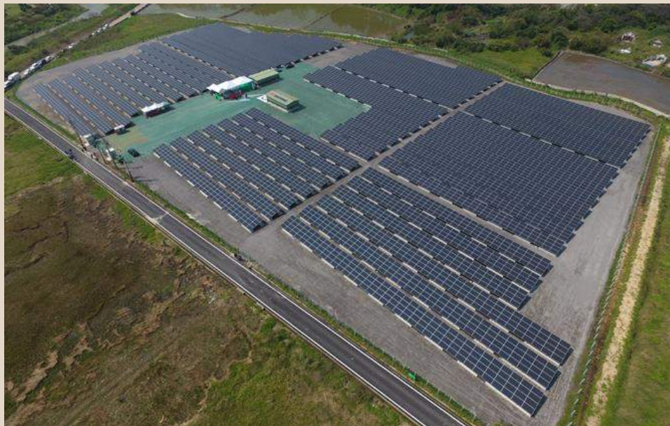
新屋後庄掩埋場2.4MW
