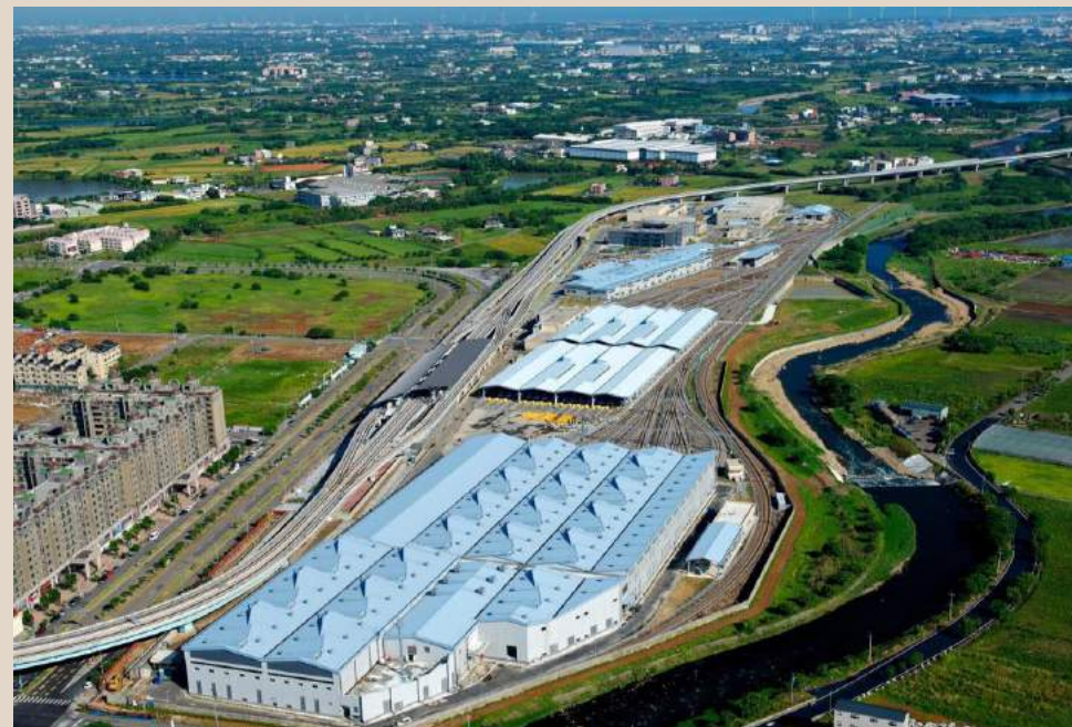
青埔機廠預計3.6MW
