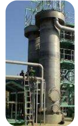
自來水公司 荊桐淨水廠 TAIWAN WATER CORP. TAIWAN Water Hardness Removal
