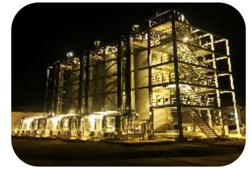
山西大同市污水處理廠 DATONG YUDONG CETP SHANXI CHINA 30,000 CMD
